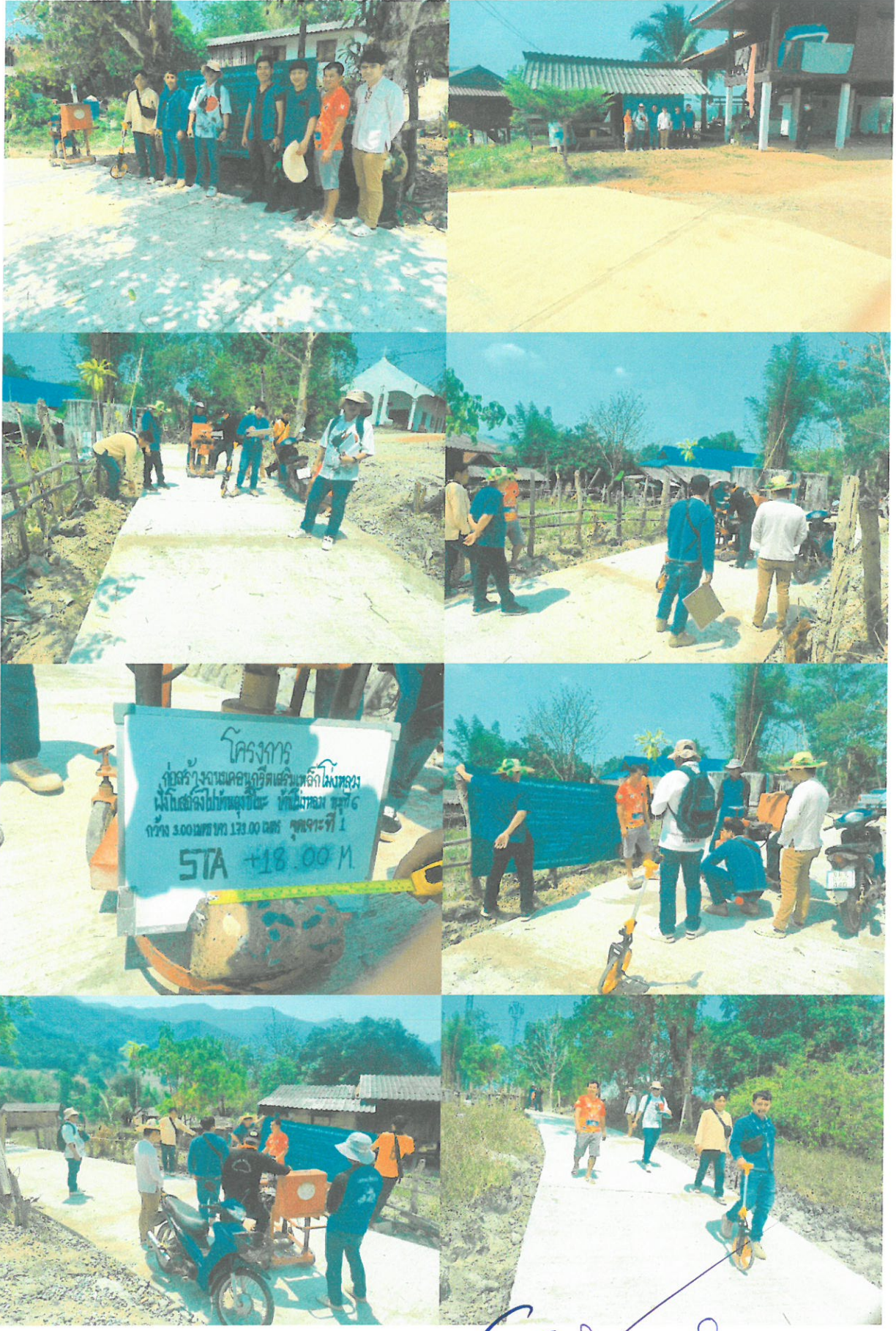
ภาพถ่ายตรวจรับงานโครงการก่อสร้างถนนคอนกรีตเสริมเหล็กโม่หลวง ฝั่งโบสถ์ลงไปบ้านลุงซิโนะ บ้านโม่หลวง หมู่ที่ ๖ กว้าง ๓.๐๐ เมตร ยาว ๑๗๓.๐๐ เมตร หนา ๐.๑๕ เมตร หรือพื้นที่ไม่น้อยกว่า ๕๑๙.๐๐ ตารางเมตร (ตามแบบ อบต.กองแขก) จำนวน ๑ โครงการ ตามสัญญาจ้างเลขที่ ๘๐/๒๕๖๘ ลงวันที่ ๑๑ กุมภาพันธ์ ๒๕๖๘
